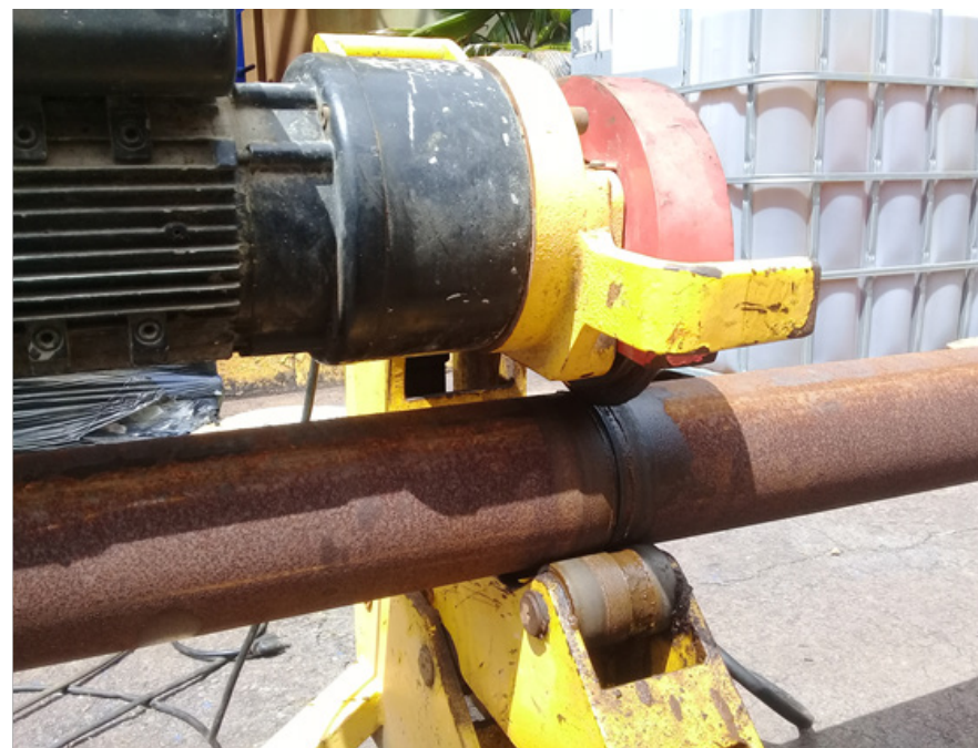
Figura 5. Procesos de manufactura de tuberías de agua contra incendio. (Elaboración propia).
